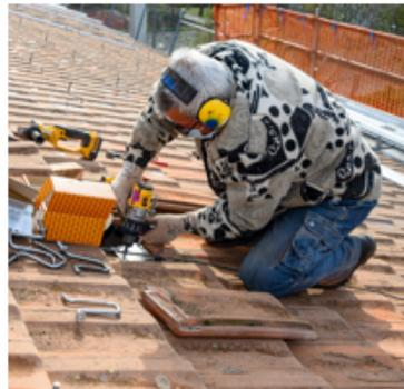
Unterkonstruktion: Aluschiene einmessen
