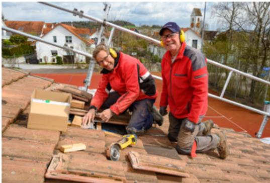
Ziegel einfräsen, Dachhaken auf Sparren verschrauben
